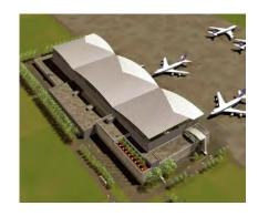
三車間飛機修理庫方案設計是與柏誠公司及美國 URS 公司的合作專案,為 Lockheed Martin 和中國南方航空公司合資公司 -- 廣州飛機維護和工程公司所設計。該方案在國際設計競賽中勝出。AYDesign 的設計方案集功能性、節能性和經濟性為一體。GAMECO 一期机库位于广州白云国际机场的维修基地,拥有目前中国跨度最大的桁架结构机库,该机库南北长 400 米,东西宽133 米,总建筑面积 9.6 万平方米,可同时容纳四架宽体飞机(如:两架空客 A380 和两架波音 B747 飞机),或 12 架窄体飞机进行各级别维修。独立的全封闭式喷漆机库采用先进的通风及温度、湿度控制系统,可容纳一架 A380 或 B747 飞机整机喷漆。
